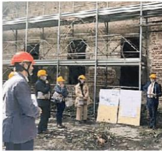
Pavia, sopralluogo al cantiere
