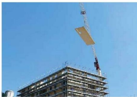
• Una parete prefabbricata raggiunge il nono piano
